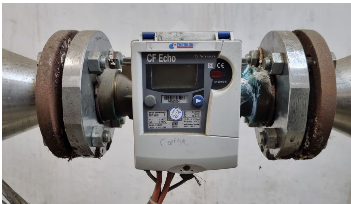
Slika 33: Merilnik toplotne energije
