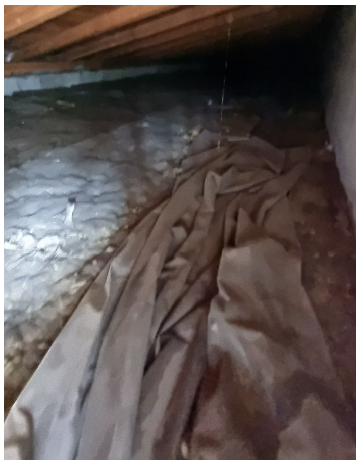
Slika 49: Neprimerno zaščitena toplotna izolacija neogrevanega podstrešja
