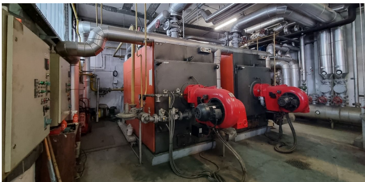
Slika 35: Kotla na zemeljski plin
