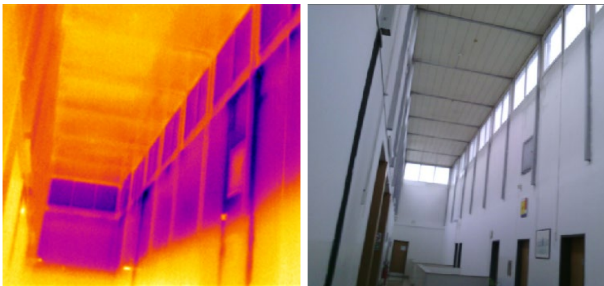
Slika 63: Neustrezno izoliran svetlobnik
