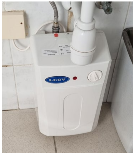
Slika 38: Lokalni bojlerji za STV
