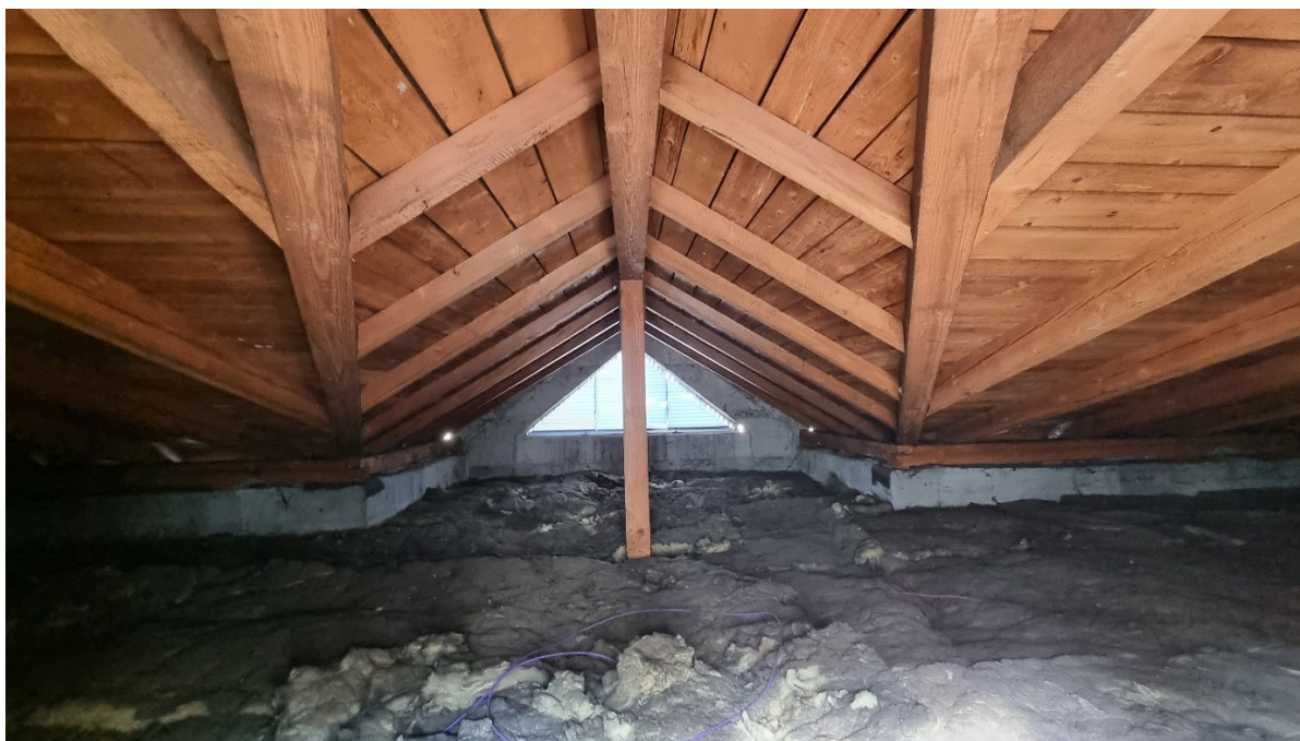
Slika 48: Leseno ostrešje, in toplotna izolacija nad stropom 2. nadstropja
