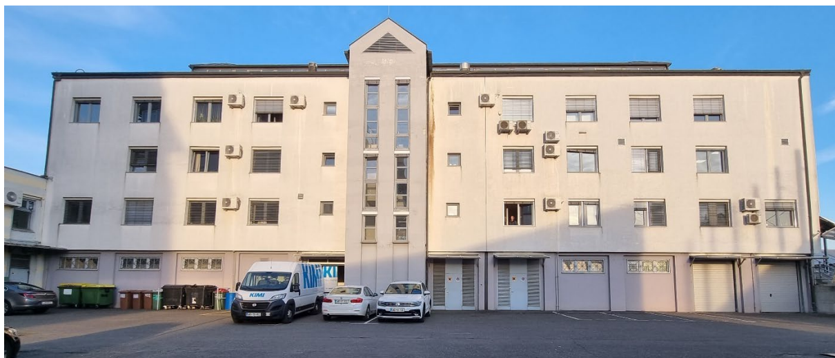
Slika 40: V fasada z neizoliranim AB stopniščem in neizoliranim podzidkom (sivo)
