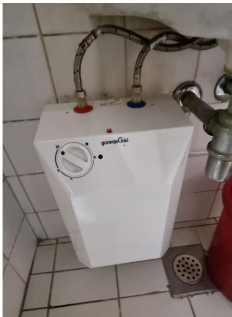
Slika 38: Lokalni bojlerji za STV
