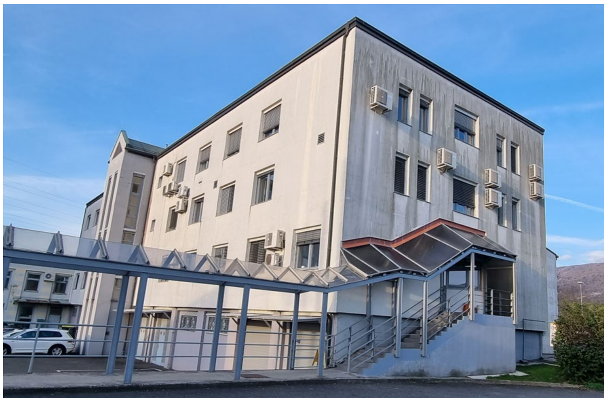
Slika 41: V fasada z neizoliranim AB stopniščem in neizoliranim podzidkom (sivo)
